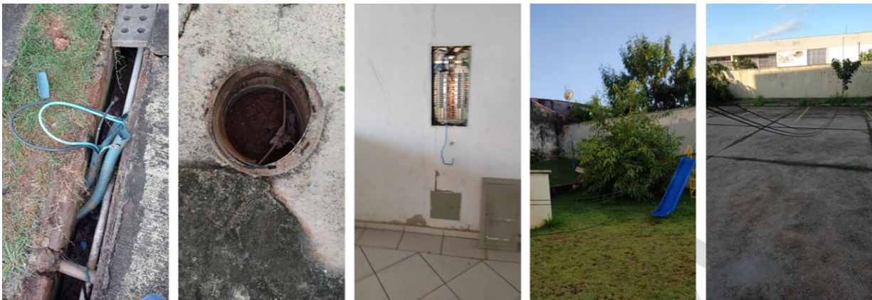
Figura 14 – EM. “Leda Therezinha Borghesi Rodrigues”. Ocorrência em 27/04: fiação de solo arrancada, caixa de energia com fios arrancados, fibra ótica arrancada. Sem energia elétrica no momento da finalização da pesquisa.
