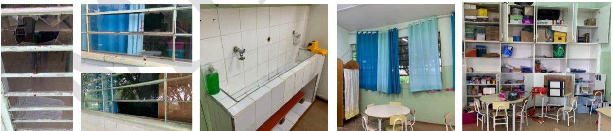
Figura 13 – CEI 52 – Olga Chibau Fornazier. Escola invadida quatro vezes desde o início da pandemia. Furto de TV, torneiras, filtros, kits escolares, grelha de ferro, quebra de vidros/janelas, bagunça em armários em busca de algo de valor.
