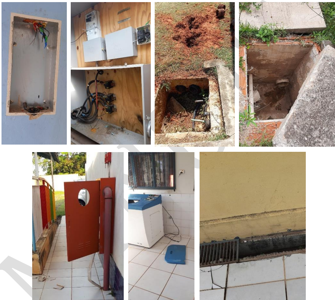
Figura 10 – CEI 93 – “Madre Teresa de Calcutá”: Cabos elétricos roubados e arrancados (sem energia há 1 ano), sem telefone, sem ventilador, itens da caixa d'água roubados (sem água), torneiras roubadas, mangueiras de incêndio roubadas, sem chuveiro, todos os datashows roubados, lousas digitais roubadas.
